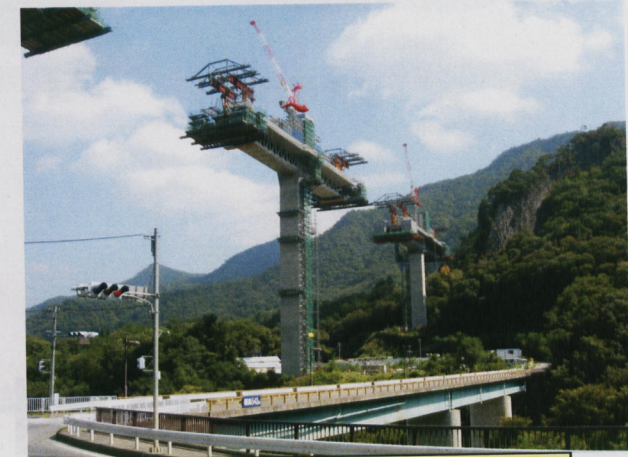
不動大橋(湖面2号橋) (H21.9月撮影)
