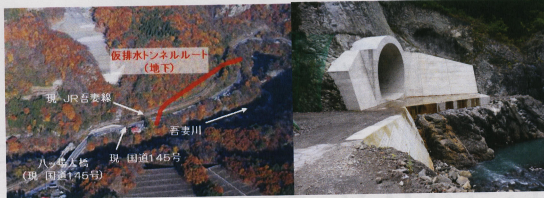
本体関連工事である 仮排水トンネル(H21.7月完成)
