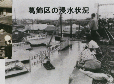
カスリーン台風被害の様子
